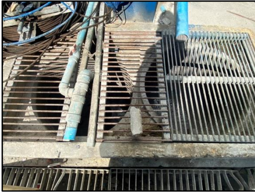
รูปที่ 39 บ่อตกตะกอนและบ่อดักน้ำสุดท้ายก่อนระบายออกจากโครงการ
