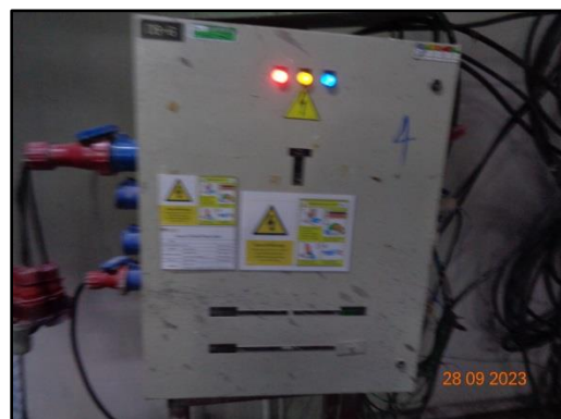
รูปที่ 46 ตู้จ่ายไฟฟ้า
