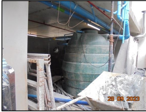
รูปที่ 36 ระบบบำบัดน้ำเสียสำเร็จรูป
