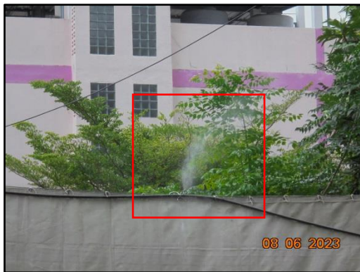
รูปที่ 11 ติดสปริงเกอร์พ่นละอองน้ำรอบบริเวณพื้นที่ก่อสร้าง
