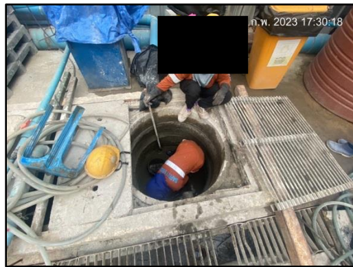
รูปที่ 39 บ่อตกตะกอนและบ่อดักน้ำสุดท้ายก่อนระบายออกจากโครงการ
