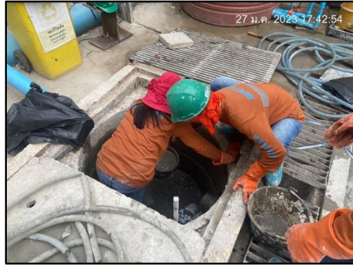
รูปที่ 40 ขุดลอกตะกอนดิน
