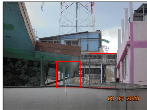
รูปที่ 11 ติดสปริงเกอร์พ่นละอองน้ำรอบบริเวณพื้นที่ก่อสร้าง
