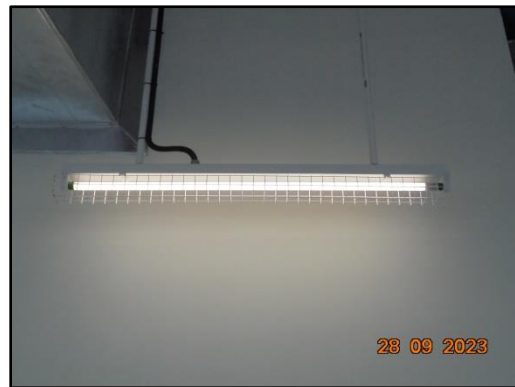
รูปที่ 47 การติดตั้งหลอดไฟฟ้าประหยัดพลังงาน (LED)
