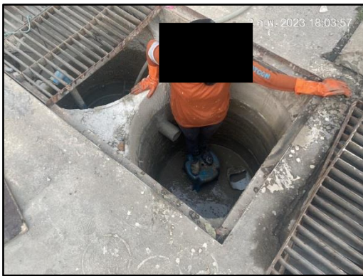
รูปที่ 39 บ่อตกตะกอนและบ่อดักน้ำสุดท้ายก่อนระบายออกจากโครงการ
